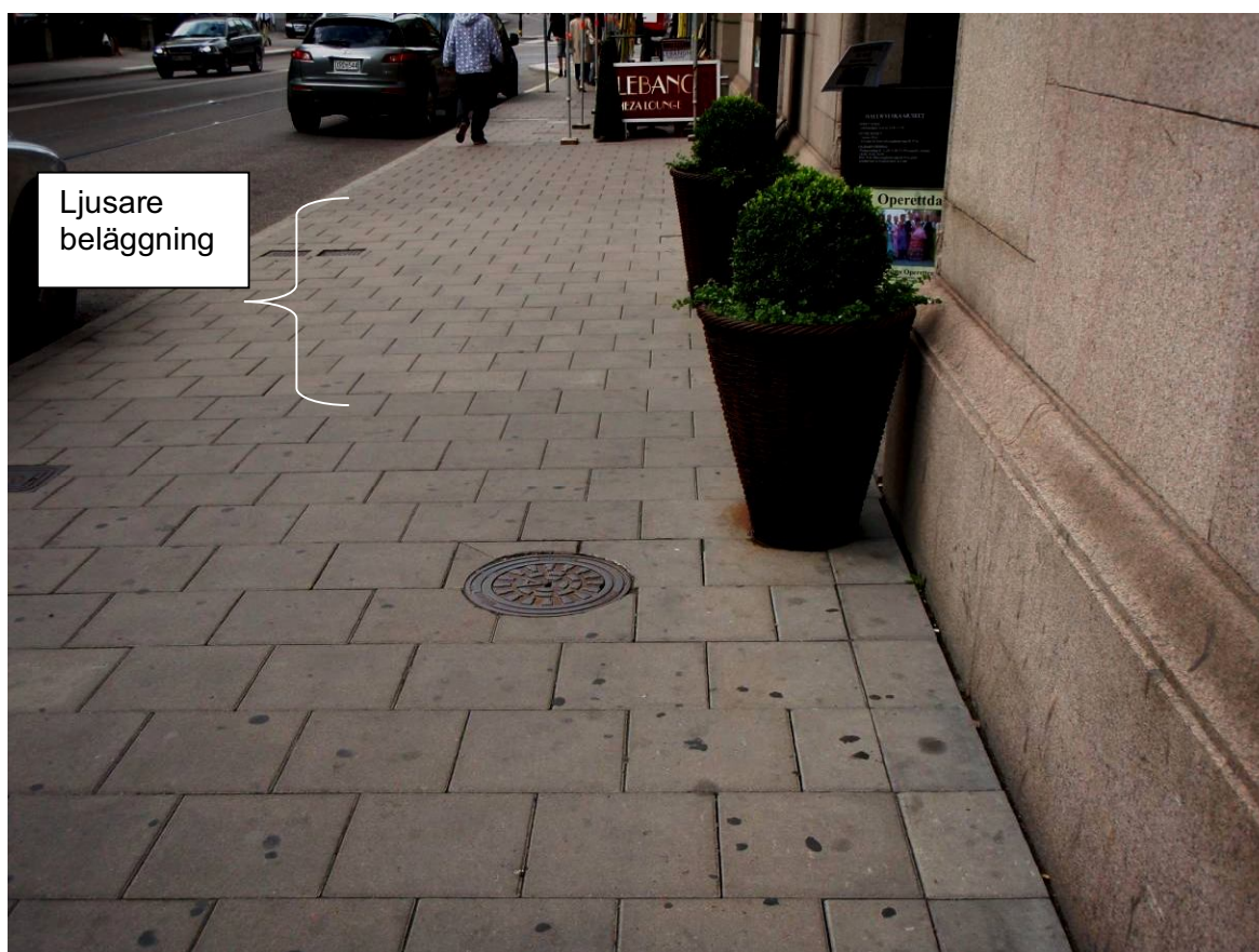
Figur 5.2 Foto av markstensbeläggning Hamngatan i Stockholm
