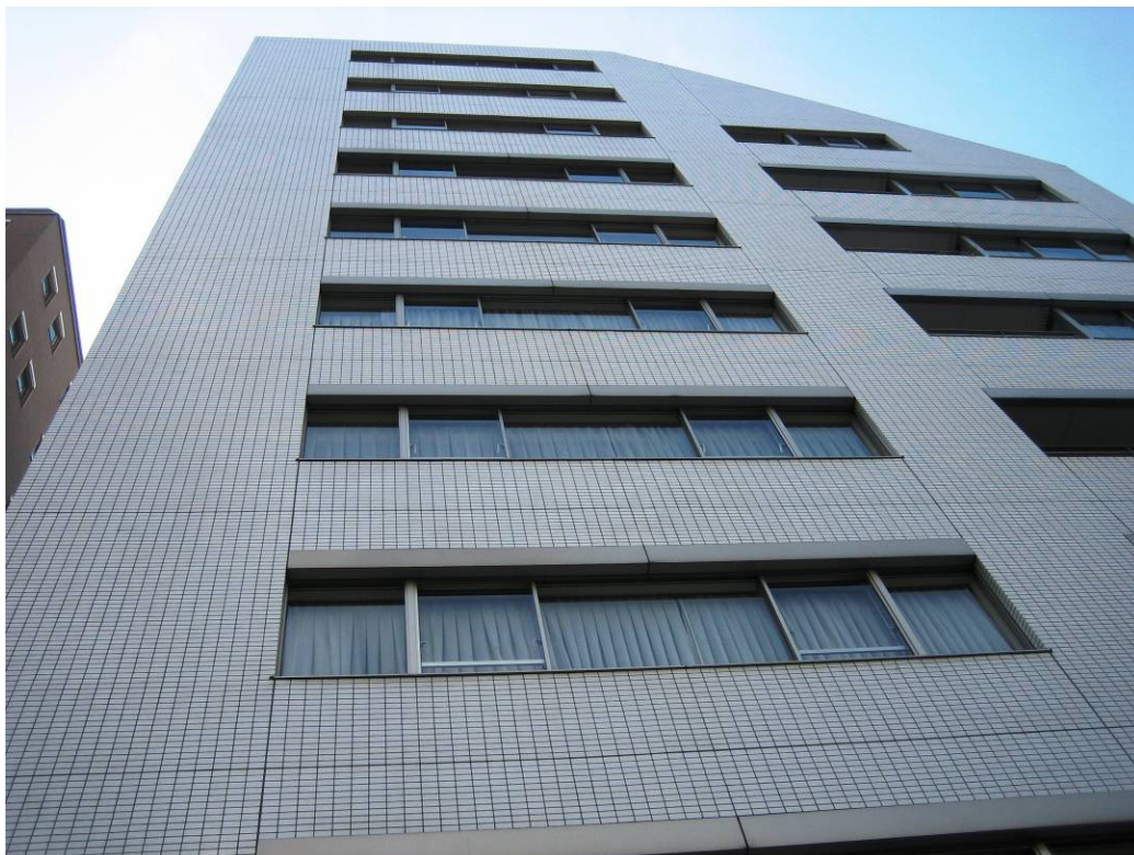
Figur 26. Husfasad med "coating" innehållande titandioxid
