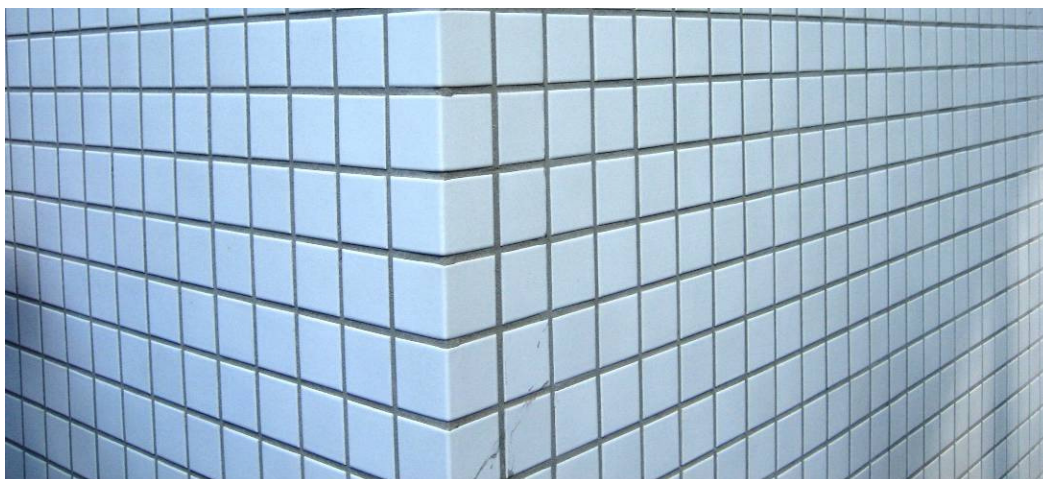
Figur 27. Detalj av husfasad med titandioxidbeläggning
